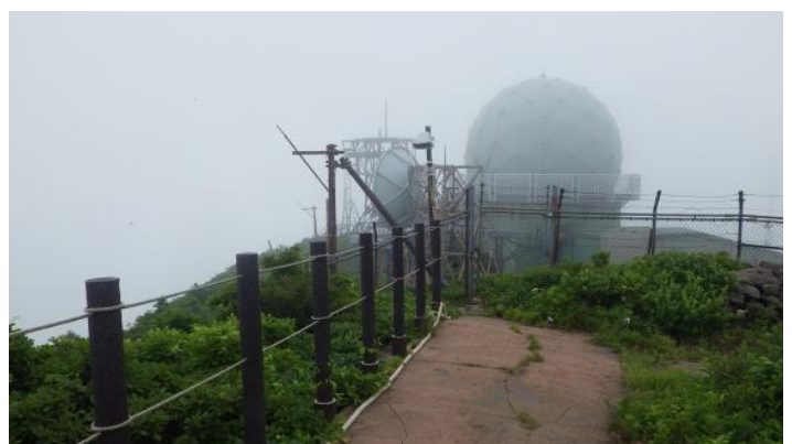
釜臥山頂上レーダードーム
