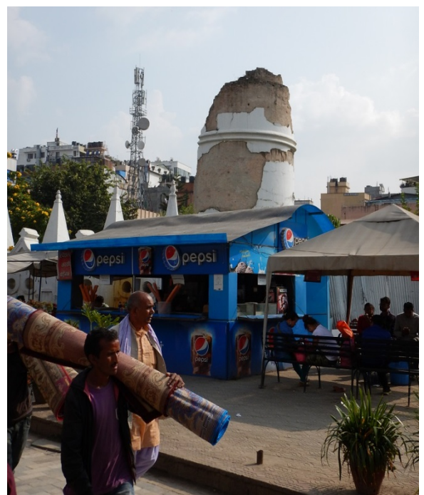
(壊れたままの煙突)
