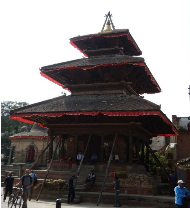
(倒れないように補強して修復中の寺院)
