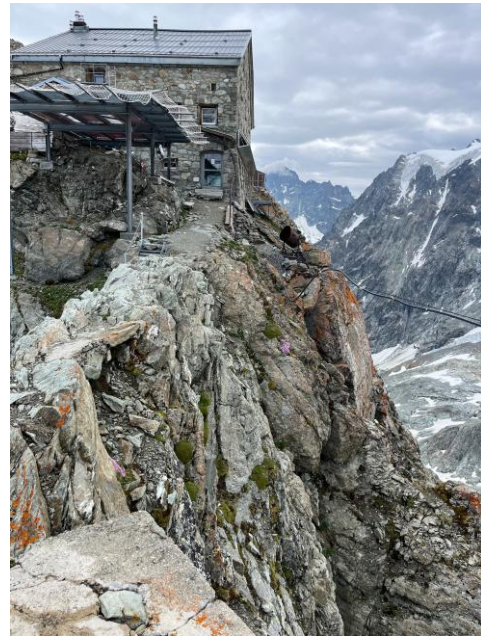
小屋の南側は切れ落ちている
